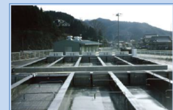
さけ・ます種苗生産施設
